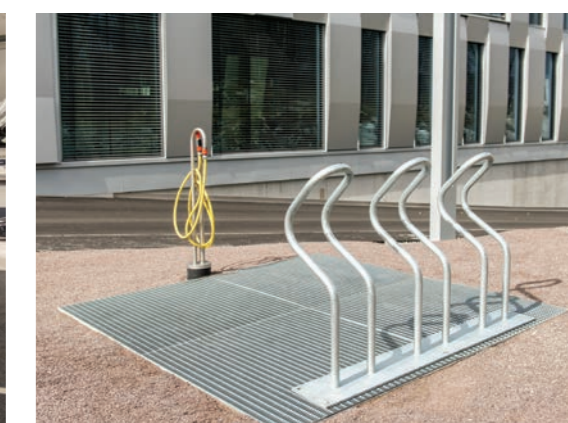
2020park har eget vaskeanlegg for sykler.
